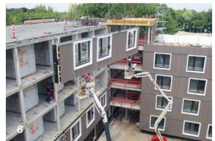
**4** Um das Gebäude später einfacher umnutzen zu können, setzten die Architekten auf ein Spannbeton-Hohldielensystem, sodass die Räume mit möglichst wenig Stützen auskommen. Die Fertignasszellen werden über eine Transportbühne eingebracht und im Anschluss geschossweise positioniert.
