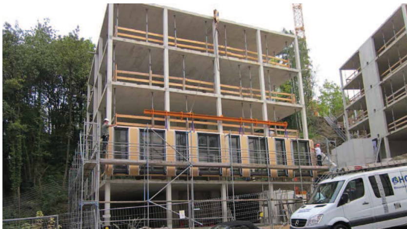
Abbildung 7: Montage vorgefertigter Holztafelelemente
