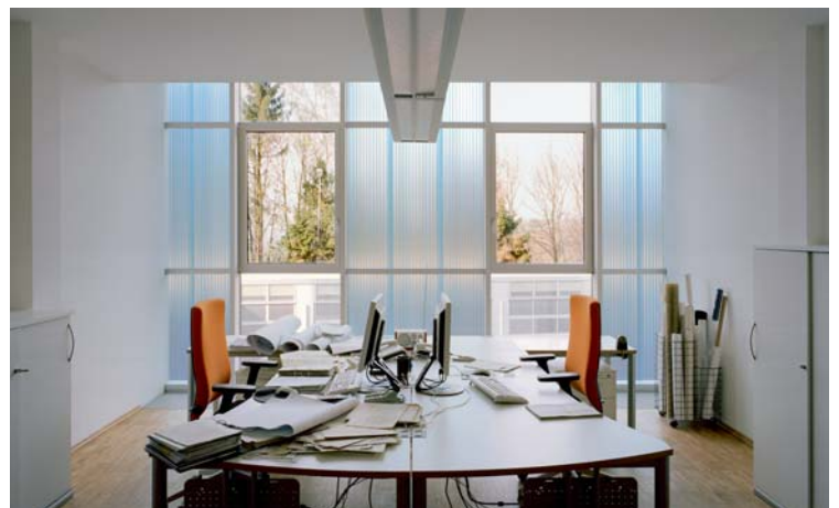
Lichtlenksysteme bringen Tageslicht in die Büros der Obergeschosse
