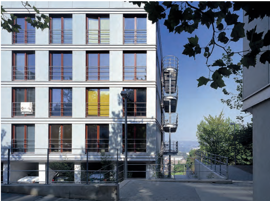
(22) Die großen Fensterflächen sind zur Belichtung der schmalen, sehr tiefen Apartments notwendig. Bei entsprechender Ausführung stellen sie keinen Widerspruch zum Passivhaus dar.
