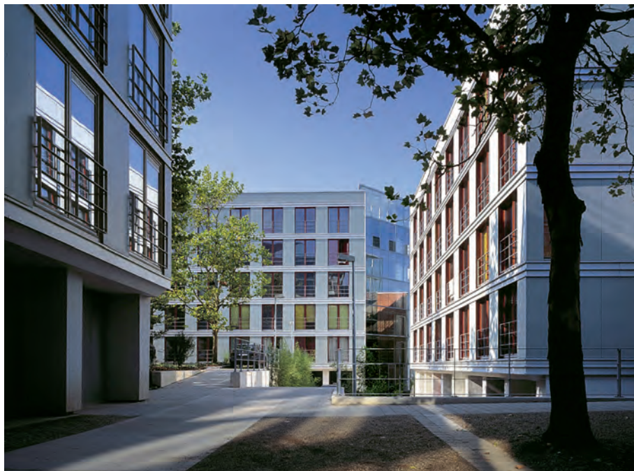
(1) Studentenwohnheim NEUE BURSE nach dem Umbau – Der Wärmebedarf des Gebäudes konnte auf unter 10 % reduziert werden.
