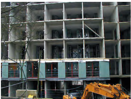
(9) Hochwärmegedämmten Fassadenelemente wurden vor den Rohbau gehängt.
