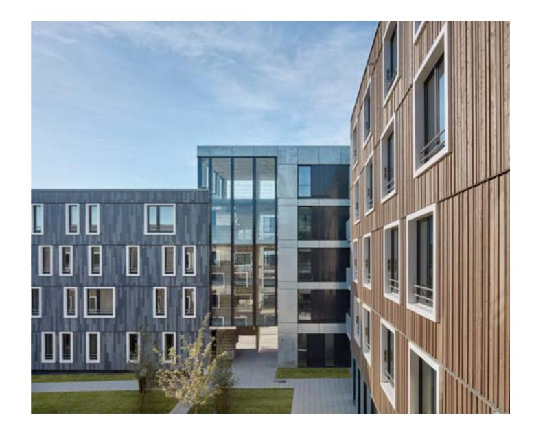
ner zeitsparenden und qualitätssichernden hohen Vorfertigung sind die Gebäude als Hybridbau konzipiert. Ein Rohbau mit weitgespannten Spannbetonhohldecken auf Stahlunterzügen und Beton-Fertigteilstützen ermöglicht größte Flexibilität. Die nicht tragenden Außenwände als vorgefertigte Holztafelwände bewirken kurze Bauzeiten bei höchsten Dämmstandards und eine CO2-Einsparung von über 400 t im Vergleich zu Massivbauweisen.
